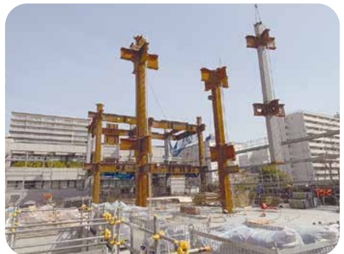
(仮称)錦糸町開発計画 新築工事
