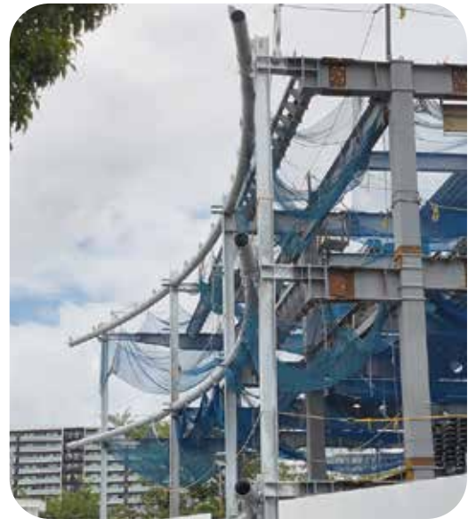
大井競馬場下見所騎手控室・馬主会館新築工事
