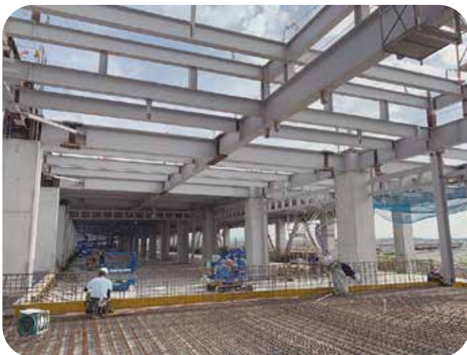
(仮称)グッドマン常総新築工事(倉庫棟)
